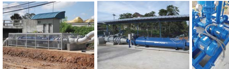
งานติดตั้งเครื่องสูบน้ำเพิ่มแรงดัน Inline booster pump installation
