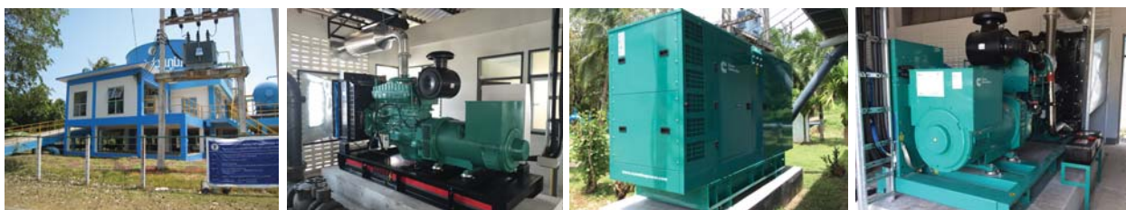
งานติดตั้งเครื่องกำเนิดไฟฟ้า Generator installation
