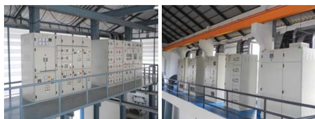
งานติดตั้งตู้ควบคุมไฟฟ้า Controller installation
