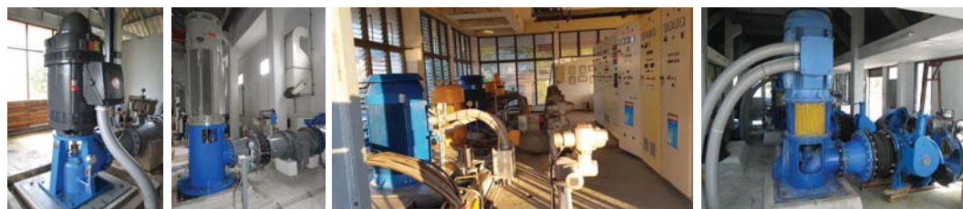
งานติดตั้งเครื่องสูบน้ำแบบเพลาตั้ง Vertical turbine pump installation
