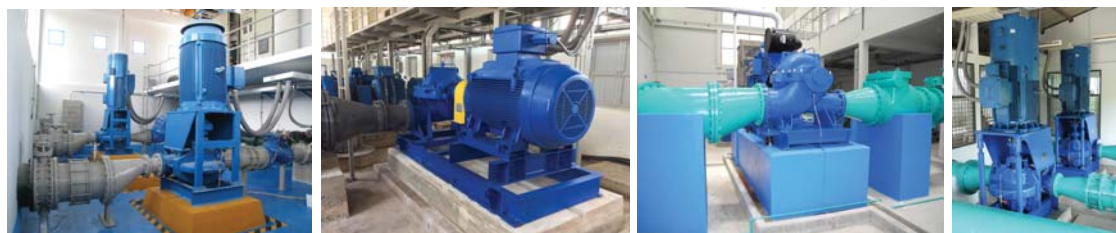
งานติดตั้งเครื่องสูบน้ำหอยโข่งแบบ Split Case Split case pump installation
