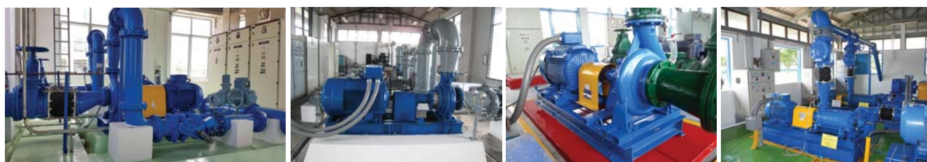
งานติดตั้งเครื่องสูบน้ำหอยโข่ง End suction centrifugal pump installation
