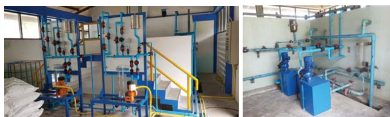
งานติดตั้งเครื่องจ่ายสารเคมี Metering pump installation
