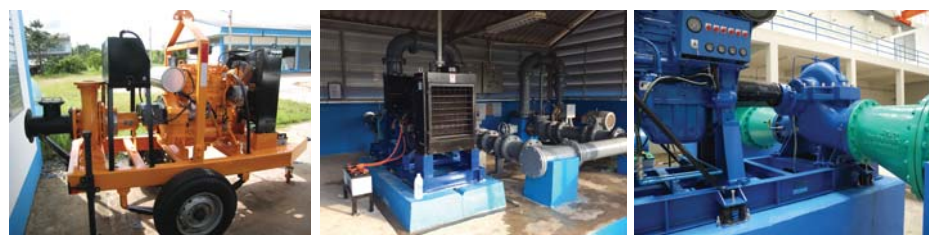
งานติดตั้งเครื่องสูบน้ำประกอบเครื่องยนต์ Pump with engine installation
