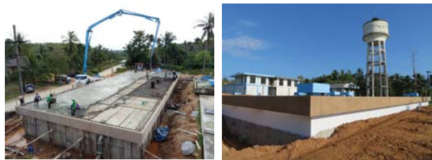
งานก่อสร้างถังน้ำใส Clean water tank construction
