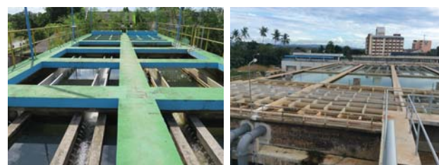
งานปรับปรุงโรงกรองน้ำ Improving purifier system
