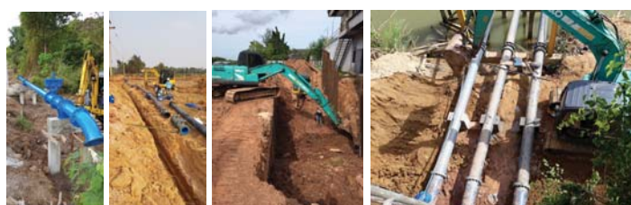
งานปรับปรุงท่อทางดูดเครื่องสูบน้ำและงานวางท่อประปาทั่วไป Improving suction pipe for pump and piping installation
